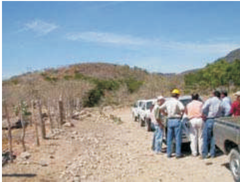
Carretera secundaria a pavimentarse con fondos de la Cuenta del Milenio – Honduras.
