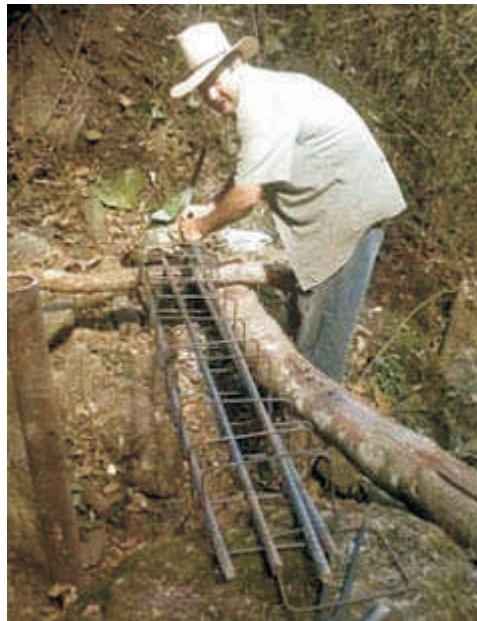
Construcción de obra toma en Sinacar, San Francisco del Valle.
