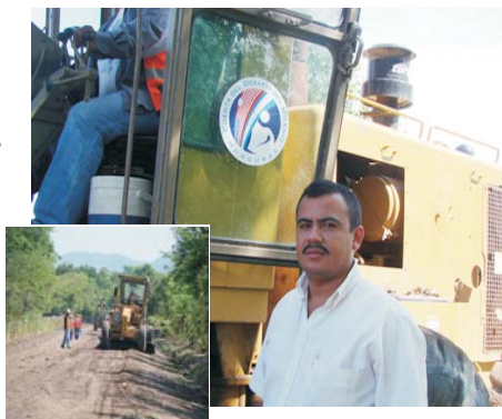
José Nahúm Calix, Alcalde de Marcovia, supervisando las obras del tramo de Buena Vista junta a técnicos de la Cuenta del Milenio – Honduras.
