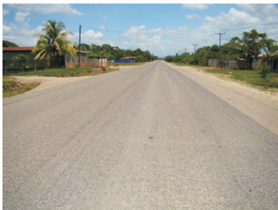
La costa norte de Honduras se verá beneficiada con la pavimentación de la carretera Sonaguera - Desvío El Coco.
