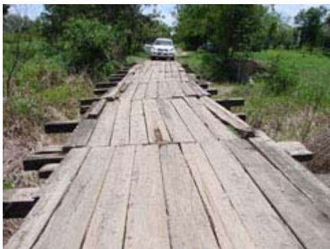
Uno de los tramos propuestos para mejoramiento.
