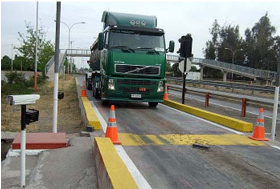
Ejemplo de una estación fija de control de pesos.
